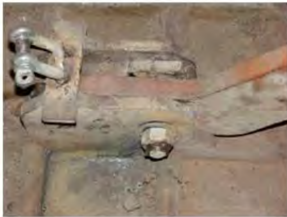
Tornillo y tuerca soldados. Sellado EBT
